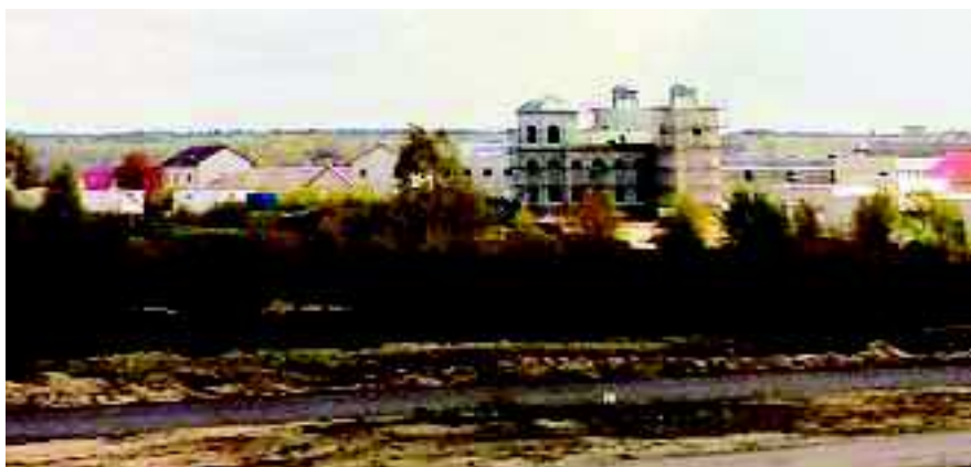
Ein Blick ins Naturschutzgebiet Colbitz-Letzlinger Heide: Die Übungsstadt Schnöggersburg entsteht mit Wohn-, Geschäftshäusern, Kaufhaus, Bank mit Hubschrauberlandeplatz, Verwaltungsgebäuden, Polizei/Gefängnis, Rathaus, Schule, Botschaft, Museum, Sakralbau und Friedhof. Foto: privat
